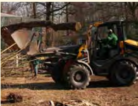
Der Bau des kleinen Pongolandes beginnt im Frühjahr mit dem Setzen der Baumstämme.
